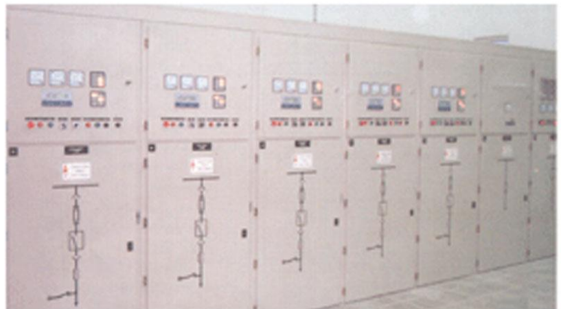
خلايا مركز توزيع توتر متوسط - استخدام داخلي MV indoor switchgears
